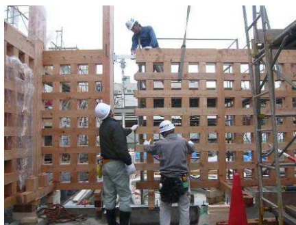
写真 5. 面格子壁の空中組み
