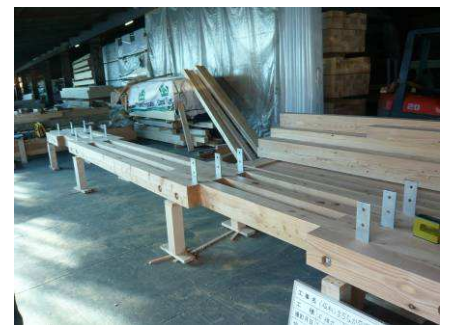
写真 4. 工場組の筏屋根・面格子壁
