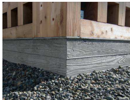
写真 6. 木目を表すコンクリート立上り
