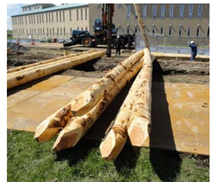
図10 パイルドラフト基礎に 用いた木杭（道産カラマツ）
