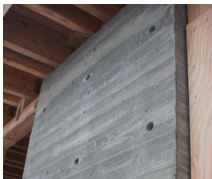
図4 木目を表現したRC壁柱
