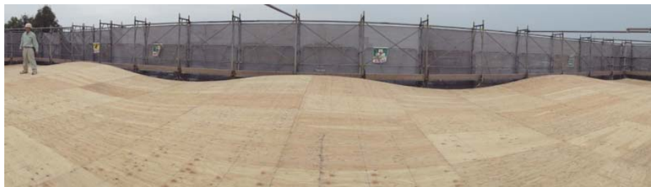
図8 コノイド曲面の木造屋根（施工中）
